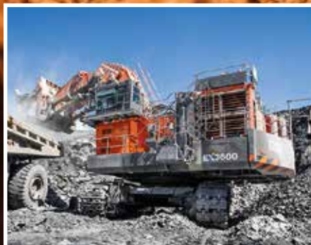
Excavadoras gigantes EX
