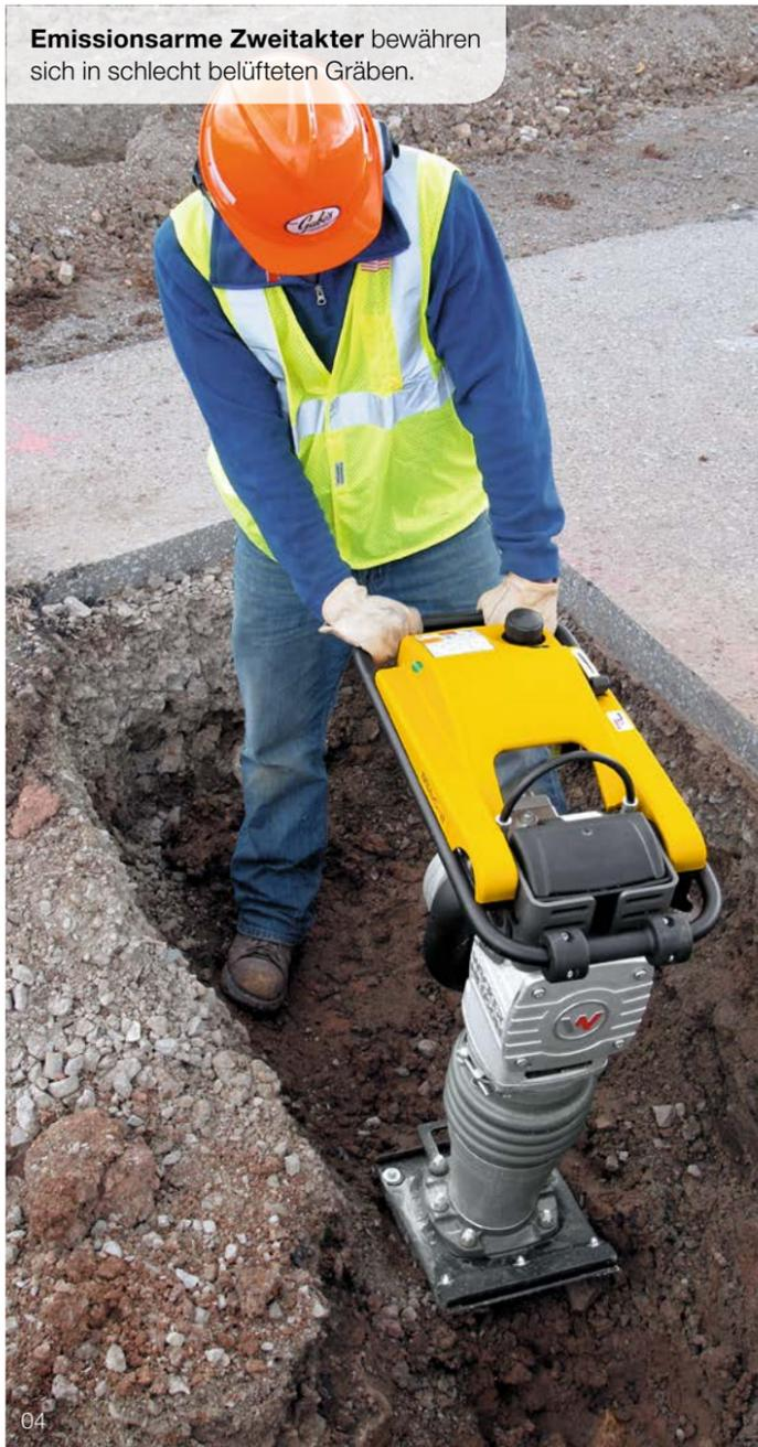
**Verdichtung an Rohren** – zentimetergenau mit dem schmalen Stampfuß des BS30.
