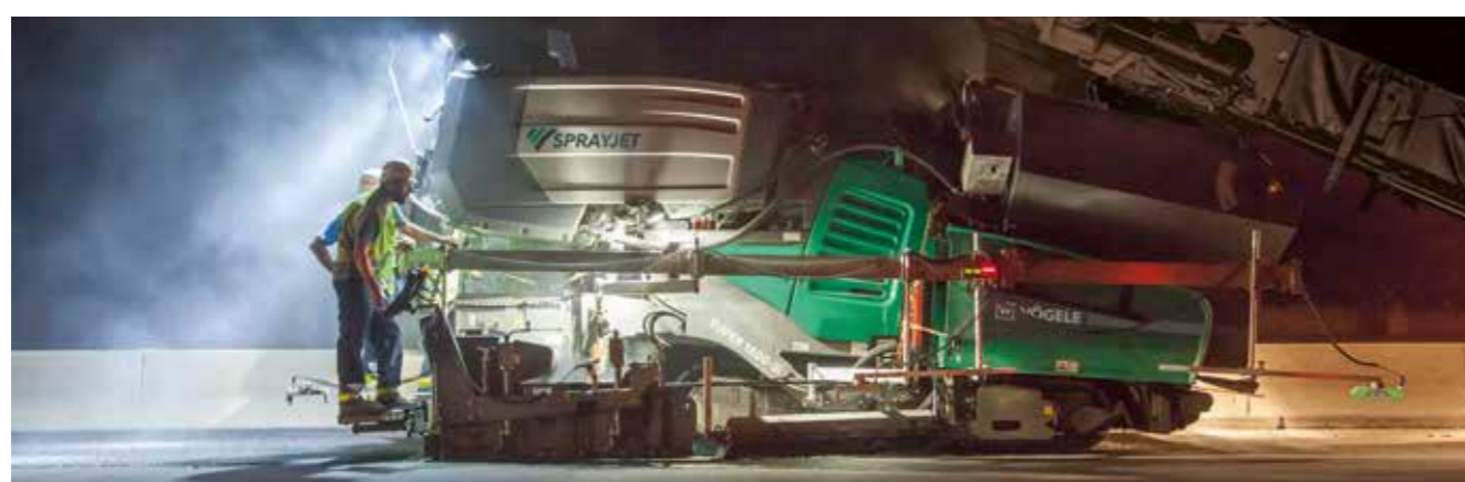
RIPRISTINO DI UN'AUTOSTRADA
