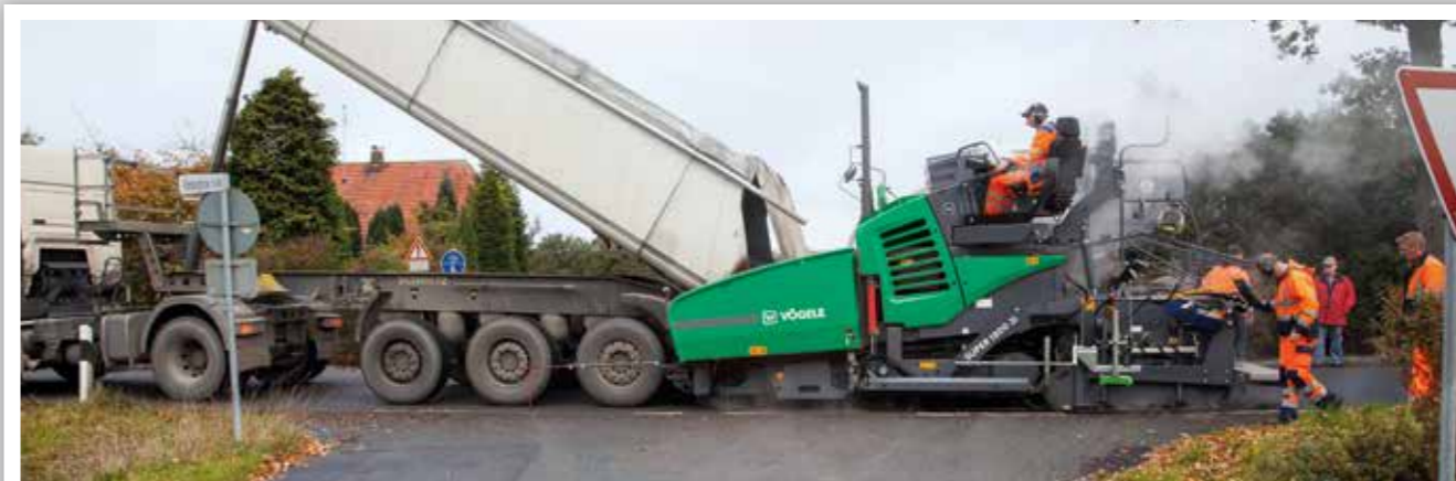
RIPRISTINO DI UNA STRADA IN UNA ZONA RESIDENZIALE
