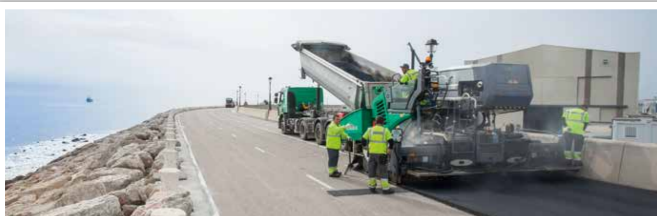
RIPRISTINO DI UNA STRADA COSTIERA
