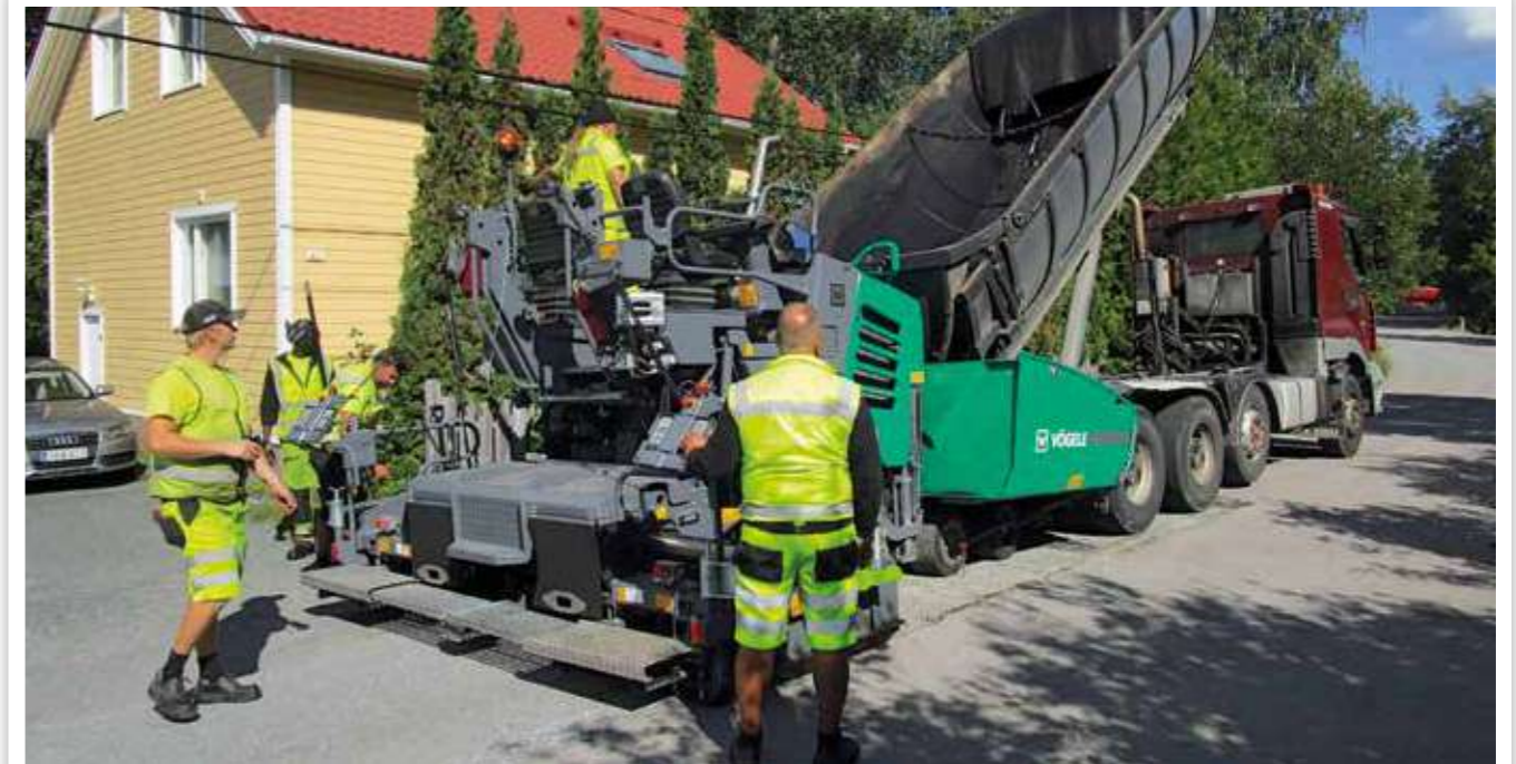
SANIERUNG VON KOMMUNALEN STRASSEN
