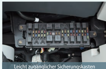
Leicht zugänglicher Sicherungskasten
