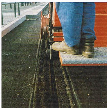
Freifräsen von Bahnschienen – innen und außen – in einem Fräsdurchgang.
