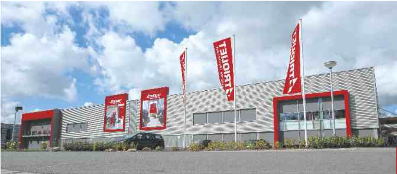
Hoofdkantoor Trioliet, Oldenzaal
