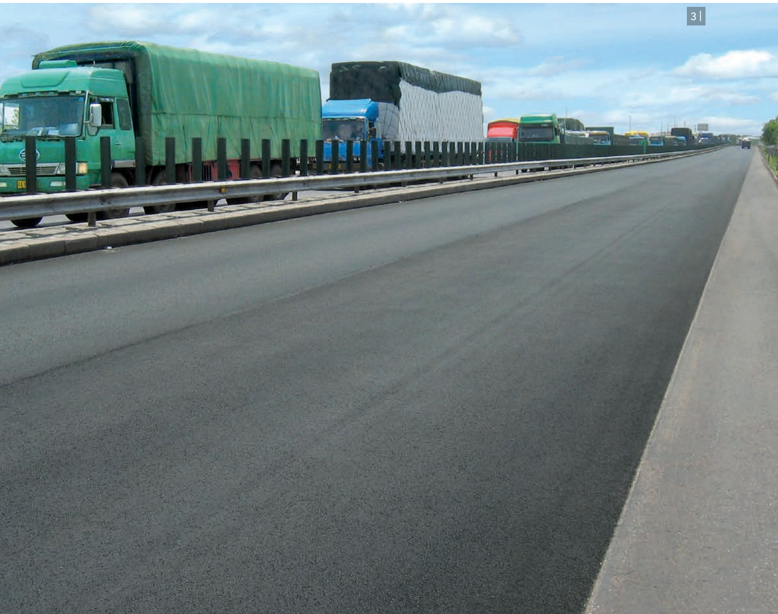
3 | Zweispurige, aus Kaltmischgut hergestellte Fahrbahn ohne Deckschicht.
