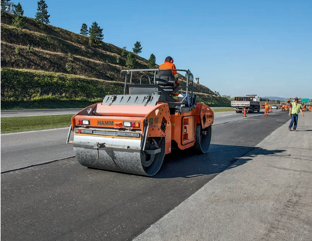
3 | Zweispurige, aus Kaltmischgut hergestellte Fahrbahn ohne Deckschicht.
