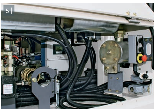
6 | Durch weit öffnende Türen sind alle Komponenten für Wartungs- und Reinigungszwecke gut zugänglich.
