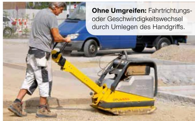
**Ohne Umgreifen:** Fahrtrichtungs- oder Geschwindigkeitswechsel durch Umlegen des Handgriffs.
