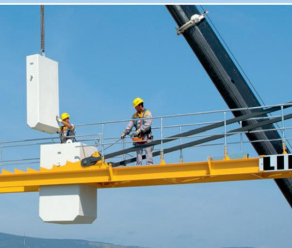
Ahorro de tiempo al poder realizar de manera simultánea la colocación de los contrapesos y el reenvío del cable de elevación.
