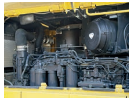
Estación de servicio centralizada
