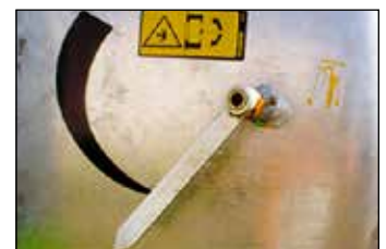
Füllstandsanzeiger mit Schwimmer
