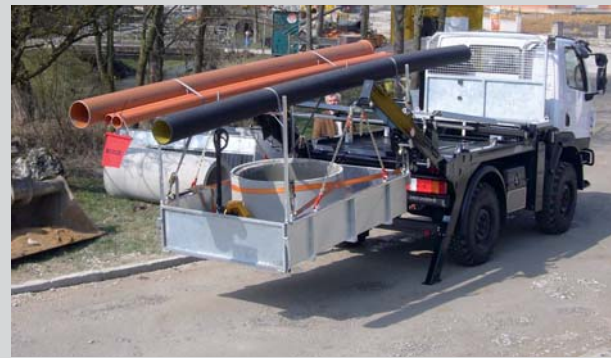
Ein mit Bauelementen beladener Flachcontainer mit H-Gestell wird waagrecht auf den Unimog geladen.
