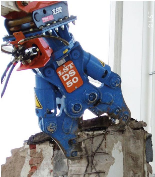
Das Zangenprofil, ausgestattet mit wechselbaren Wellenmessern für das Schneiden der Armierungen, und auswechselbaren Zähnen, ermöglicht das schnelle Arbeiten auch unter komplizierten Bedingungen. Die Kombizange DS ist mit ihren zwei geschützten Zylindern in der Lage, innerhalb kürzester Zeit größtmögliche Schneidkraft aufzubauen.
