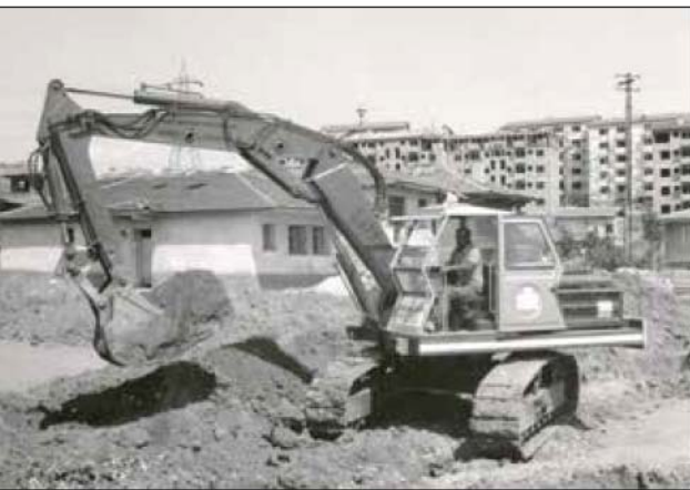
1976: S 517 mit Raupenfahrwerk und Kunststoffkabine im Erdbau
