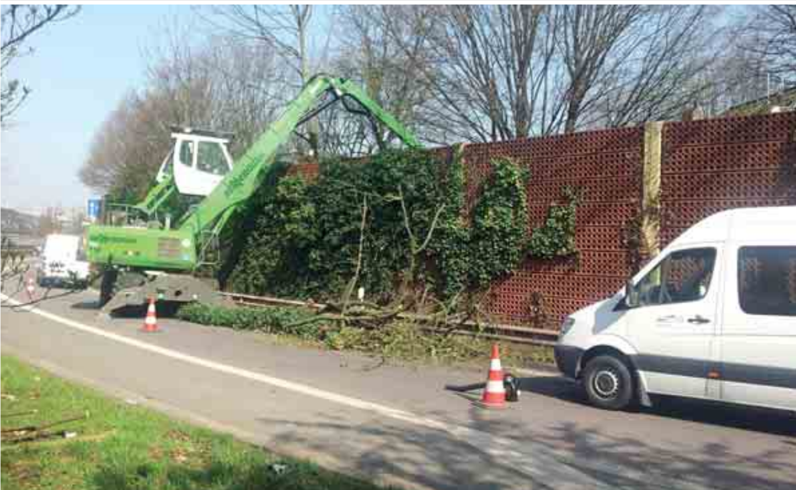
718 - trabajos de acondicionamiento de vías también sobre muros protectores; Alemania
