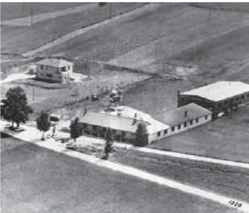
Planta de Pilling, años 50 – los inicios Завод в Пиллинге, 50-е годы – начало
