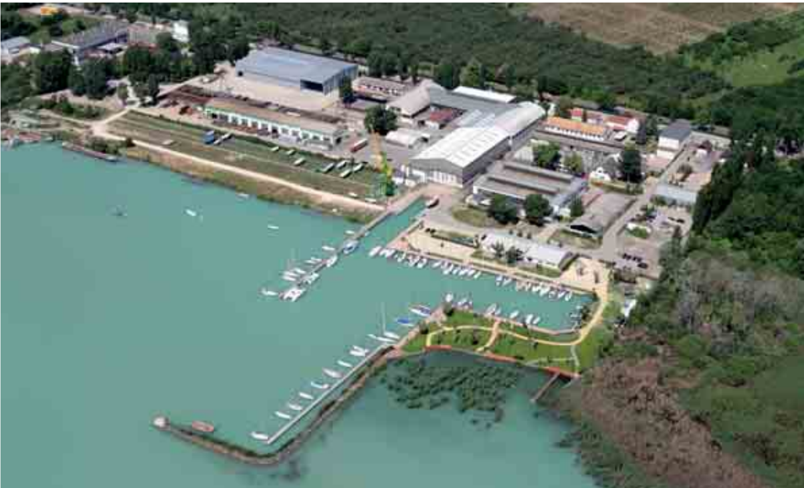
Planta de Balatonfüred/Hungría – fabricación de componentes estructurales soldados y de acero Завод Балатонфюред/Венгрия – производство сварных металлоконструкций
