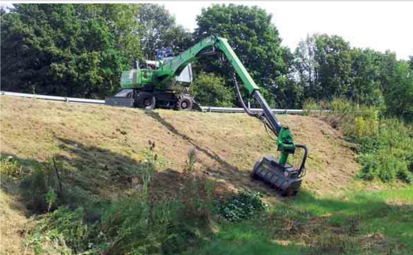
718 – desbroce en laderas cuesta abajo como trabajos de mantenimiento de terraplenes junto a carreteras; Alemania 718 – мульчирование вниз по склону как работы по благоустройству дорог; Германия
