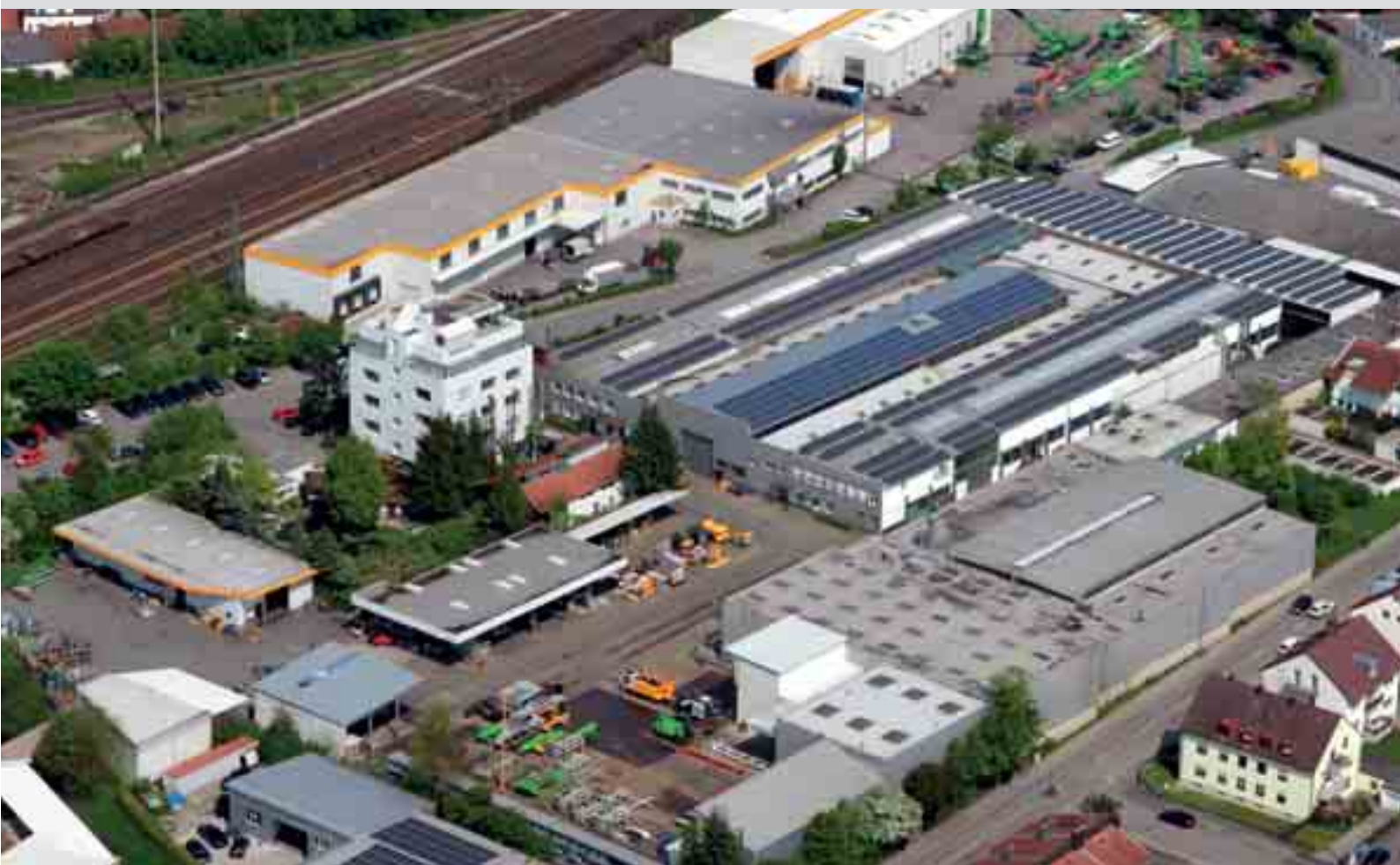
Planta 1 y centro de piezas de repuesto, Straubing – sede de la empresa (desde 1959) Завод 1 и центр запчастей, Штраубинг – штаб-квартира предприятия (с 1959 г.)
