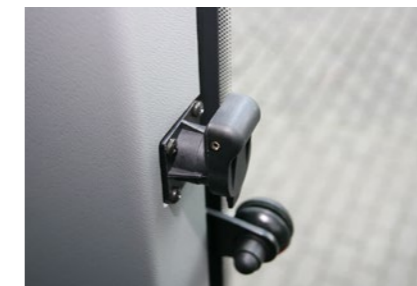
Steckdose mit Dauerstrom
